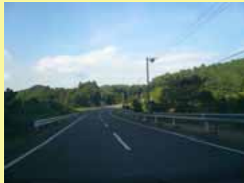
供用済み区間（筒森橋付近）
