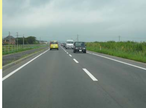
銚子市側から かもめ大橋方面を望む
