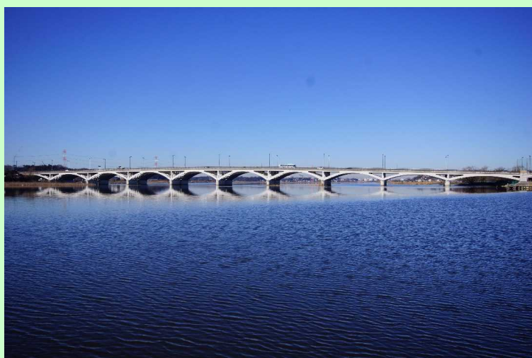
現在の千葉県におけるアーチ橋の例（手賀大橋） 提供：我孫子市
