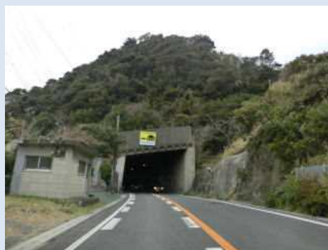
元名第二トンネル(当時の明鐘トンネル付近)
