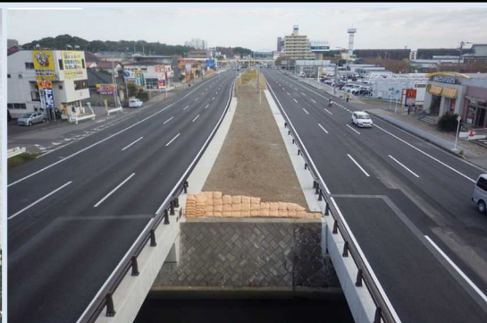
現在の国道14号（千葉市稲毛区付近） （国道357号との重複区間） 出典：千葉国道事務所
