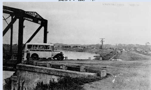
葛飾橋を渡る路線バス（木橋から鉄橋へ架け替え後） 提供：松戸市
