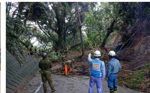
自衛隊による道路啓開
