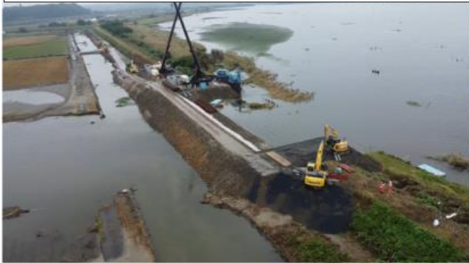
東洋建設(日本建設業連合会)による 道路啓開作業
