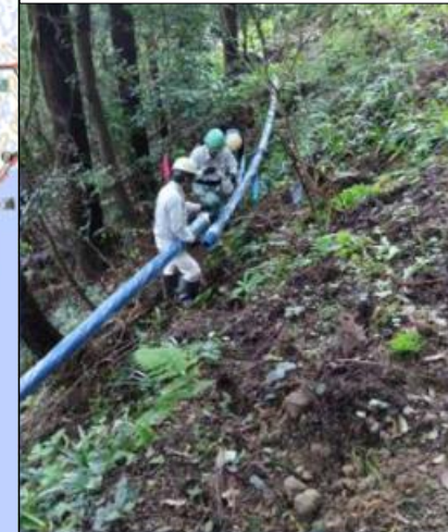
仮配管による 断水復旧作業
