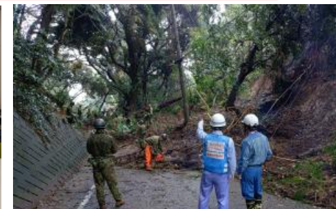
自衛隊による道路啓開
