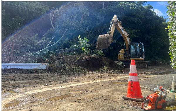
中央建設(千葉県建設業協会)による 道路啓開作業
