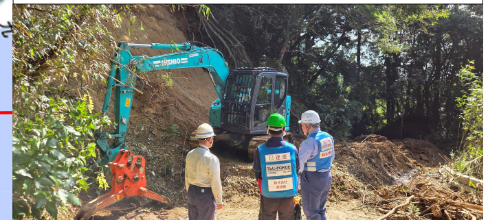
鴻池組(日本建設業連合会)による 道路啓開作業
