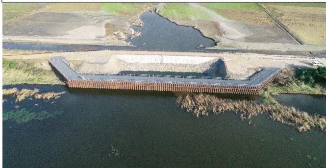
北印旛沼の緊急復旧完了 10月15日(木)
