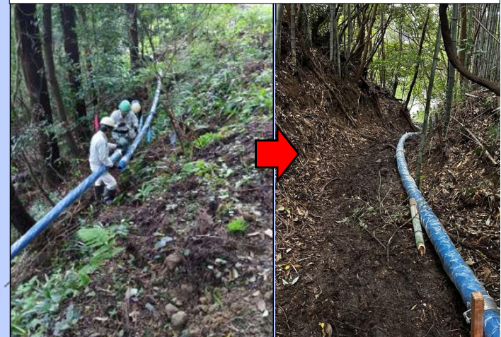
仮配管による断水復旧作業完了 10月2日(金) 17時30分 断水解消
