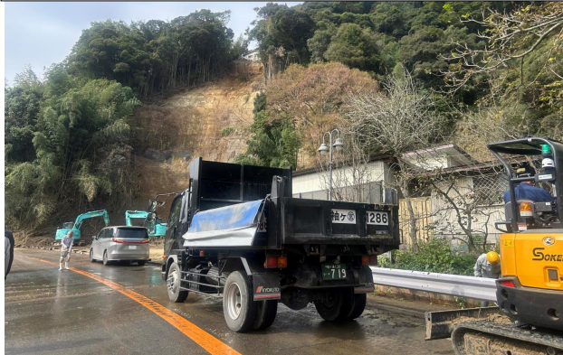
三枝組(千葉県建設業協会)による 道路啓開作業
