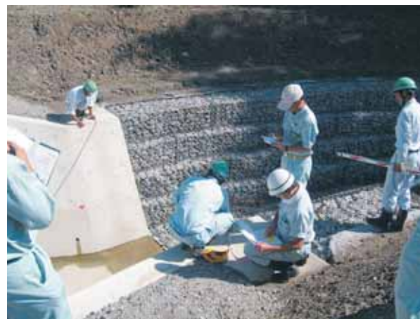
地すべり対策工事の検査状況
