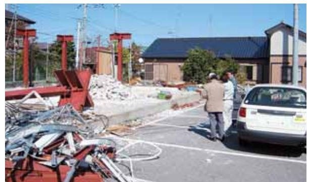
解体工事現場のパトロール
