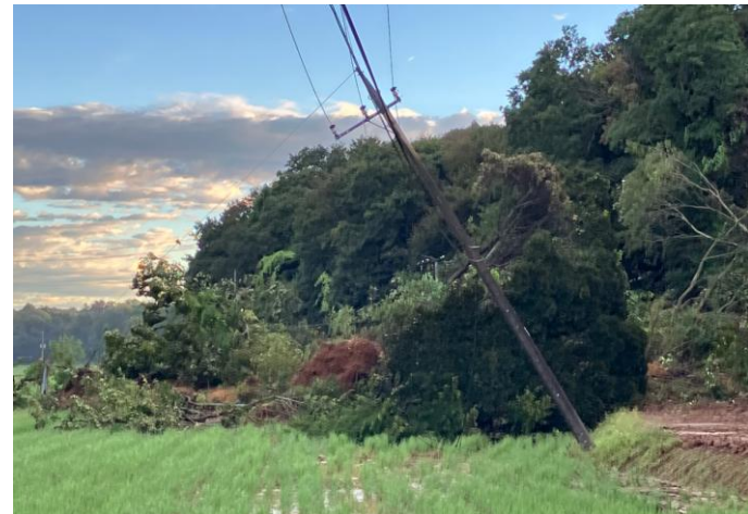
＜倒木による通行路寸断＞
