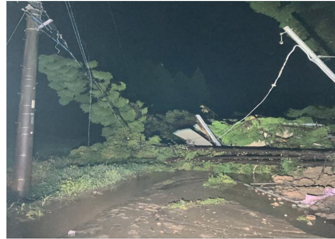
＜倒木による通行路寸断＞
