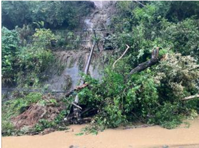
＜土砂崩れによる設備流出＞
