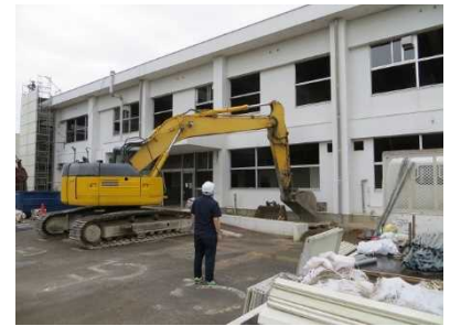
解体工事現場へのパトロール
