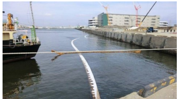
油吸着マットによる流出油の除去
