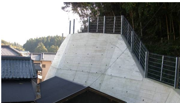
張りコンクリート工（いすみ市大原）
