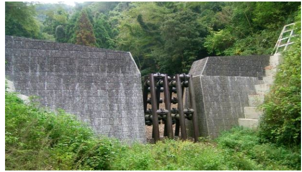
砂防堰堤工（南房総市合戸）
