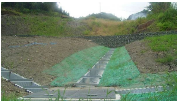
明暗渠工（南房総市山田）
