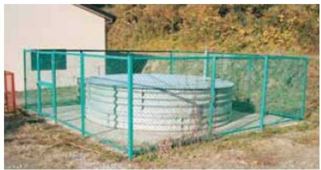
集水井工（南房総市大井）
