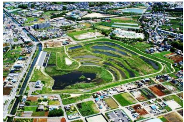
大柏川第一調節池 (市川市北方町)
