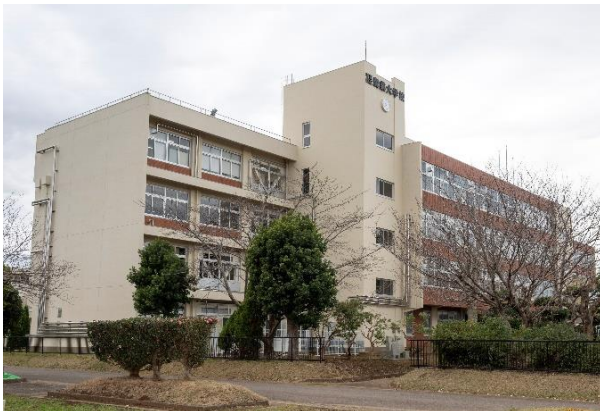
県立農業大学校本校舎大規模改修工事
