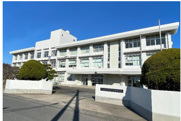
県立旭高等技術専門校管理棟改修工事
