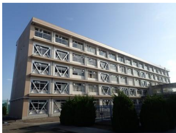
館山総合高等学校校舎工業棟（耐震改修）
