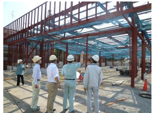
建築パトロールの様子
