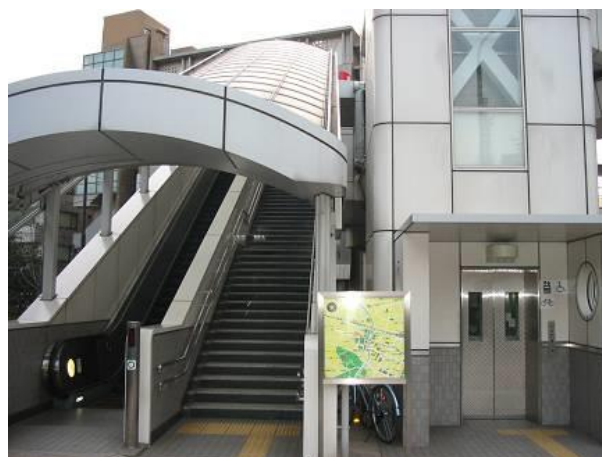
エレベーター、エスカレーター、階段が隣接して設置され、移動手段が選択できるよう整備された例
