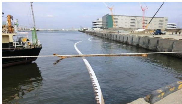
油吸着マットによる流出油の除去
