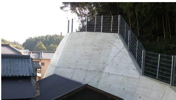
張りコンクリート工（いすみ市大原）
