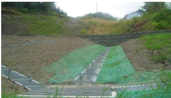
明暗渠工（南房総市山田）
