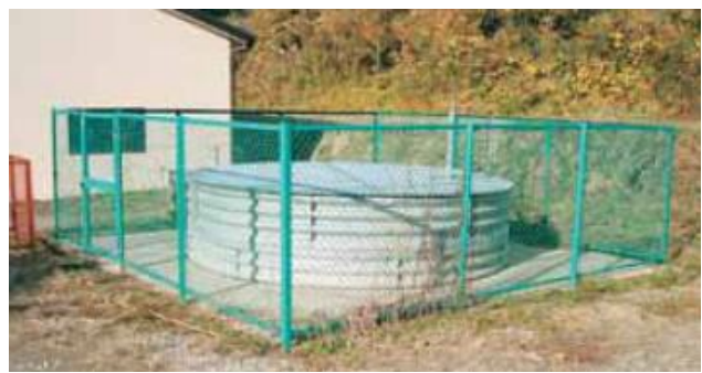
集水井工（南房総市大井）
