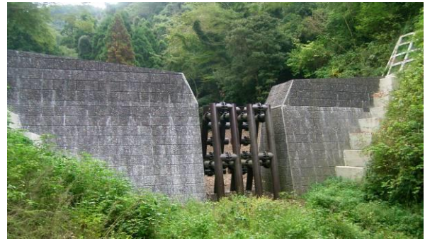
砂防堰堤工（南房総市合戸）
