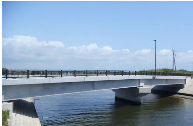
新川大橋（匝瑳市）
