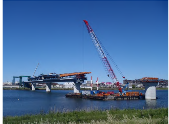
県道船橋行徳線（仮称）妙典橋（市川市）
