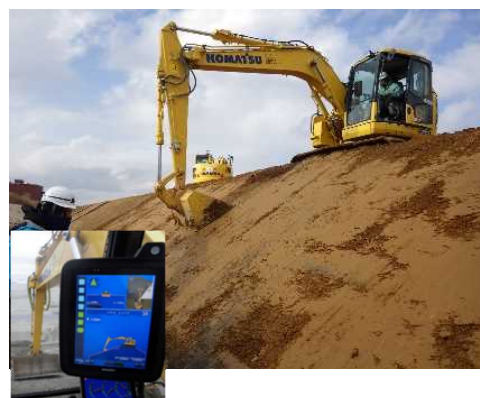
ICT活用工事
