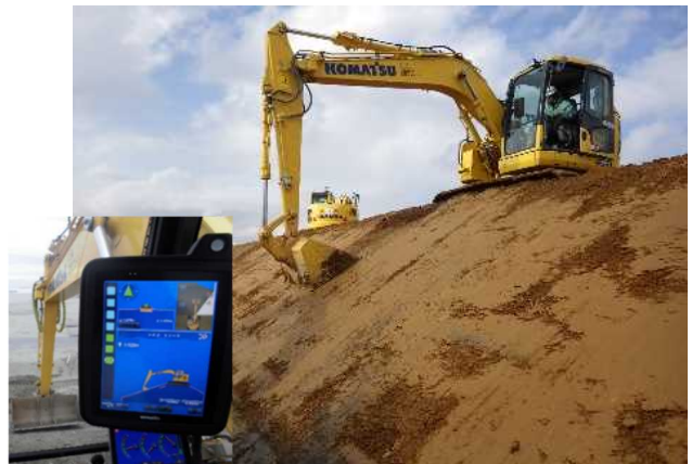
ICT活用工事
