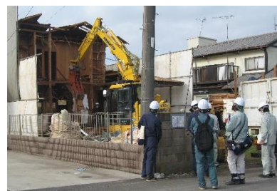
解体工事現場のパトロール
