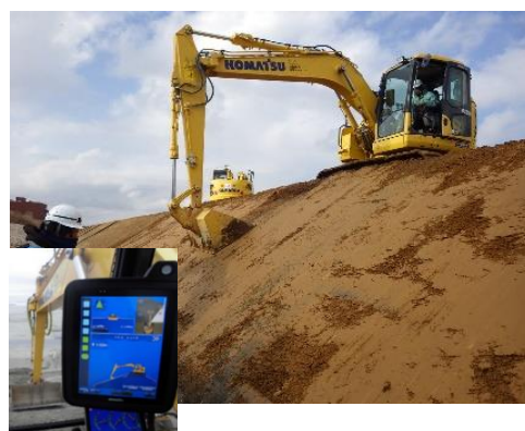
ICT活用工事
