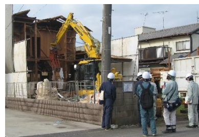
解体工事現場へのパトロール
