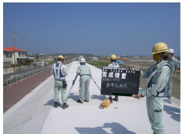
海岸工事の検査
