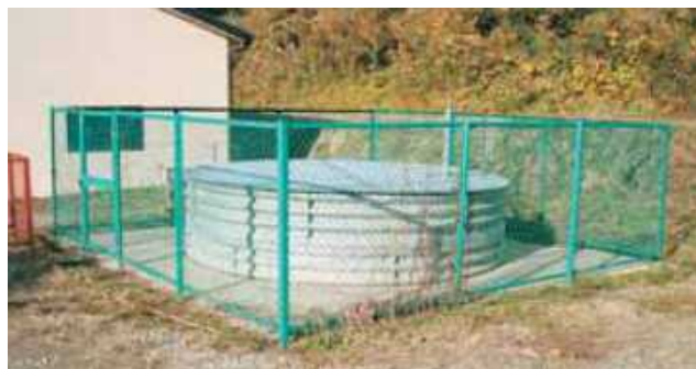
集水井工 (南房総市大井)
