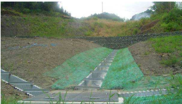
明暗渠工 (南房総市山田)
