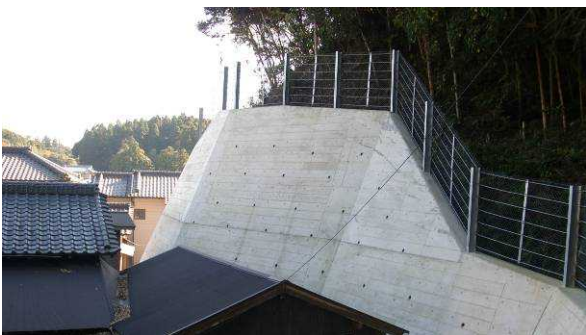
張りコンクリート工 (いすみ市大原)
