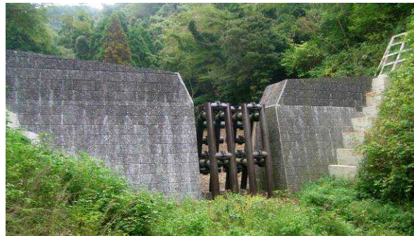
砂防堰堤工 (南房総市合戸)
