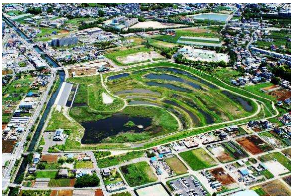
大柏川第一調節池 (市川市北方町)
