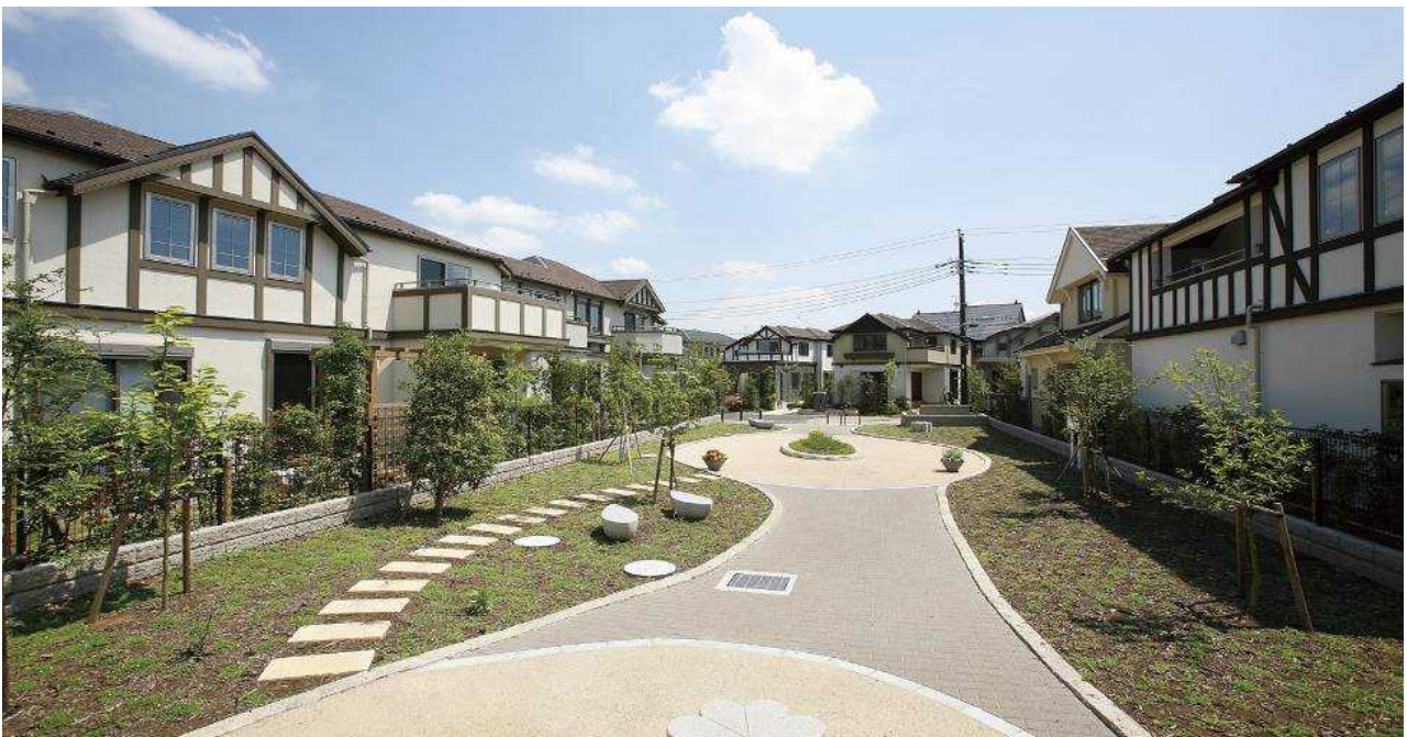
建築協定により建築物の敷地、用途、形態について制限を加えて、住宅地としての良好な環境を維持・増進した例
