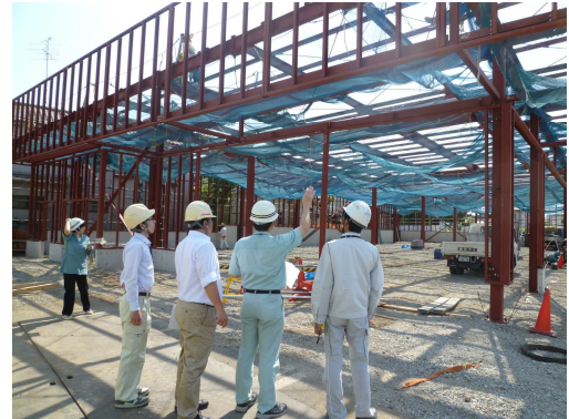
建築パトロールの様子
