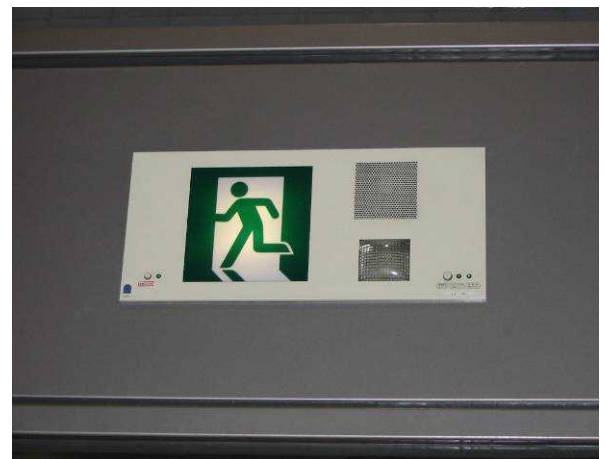
避難誘導の表示(左のピクトグラム)と非常時に点滅するフラッシュランプ(右下)と、非常放送用のスピーカー(右上)により、複数の方法で緊急情報を提供している例
