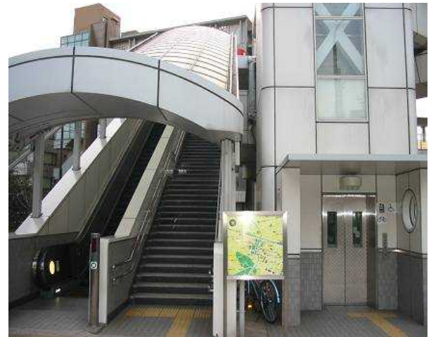
エレベーター、エスカレーター、階段が隣接して設置され、移動手段が選択できるよう整備された例
