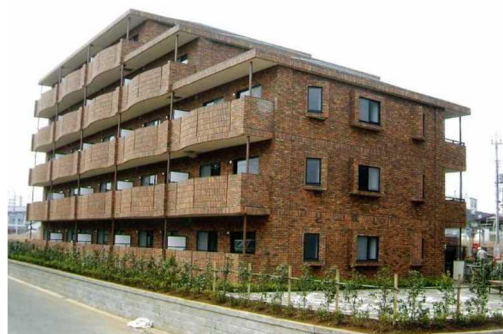
特定優良賃貸住宅(ノーブル東松戸:松戸市)
