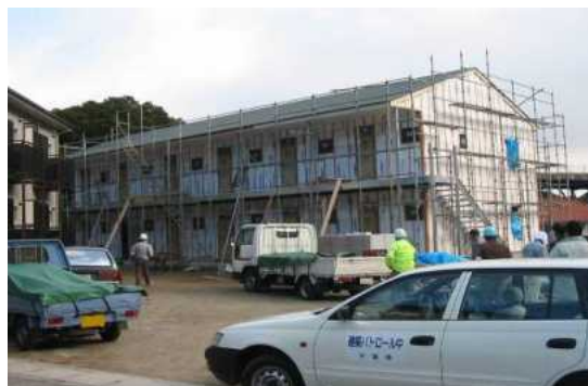
建築パトロールの様子
