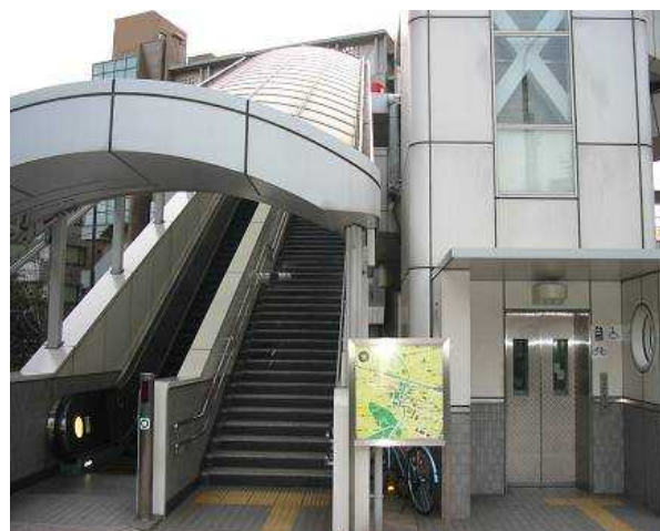
エレベーター、エスカレーター、階段が隣接して設置され、移動手段が選択できるよう整備された例
