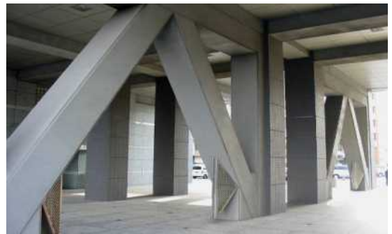
県有施設の耐震改修
