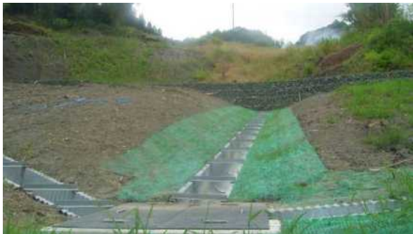
明暗渠工（南房総市山田）
