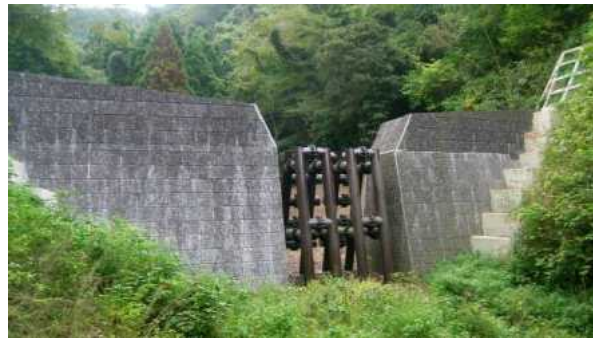
砂防堰堤工（南房総市合戸）
