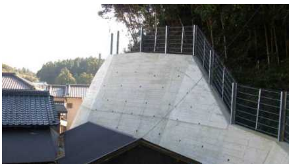
張りコンクリート工（いすみ市大原）
