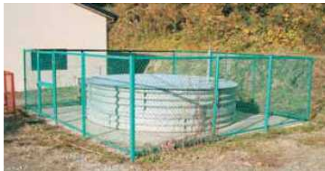
集水井工（南房総市大井）
