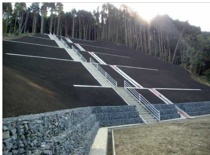
がけ崩れから身を守る施設の整備 (いすみ市)
