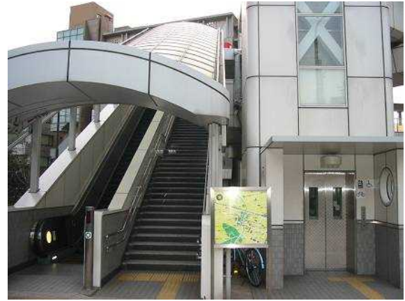
エレベーター、エスカレーター、階段が隣接して設置され、移動手段が選択できるよう整備された例
