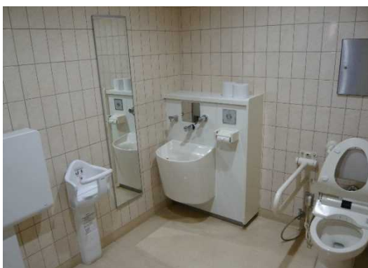
車椅子使用者やオストメイト、子ども連れ等、多様な方が利用できる多機能トイレの例
