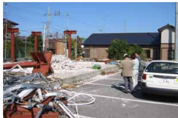
解体工事現場のパトロール
