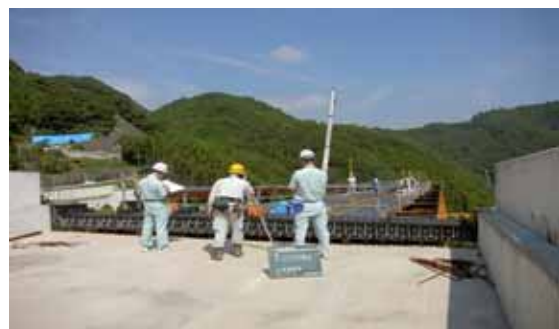
橋梁工事の検査状況
