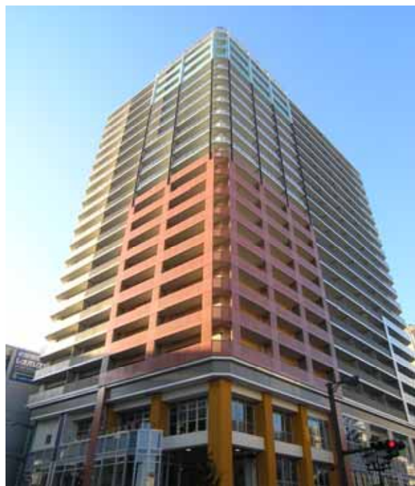
船橋本町 1 丁目地区（ルナパーク船橋）
