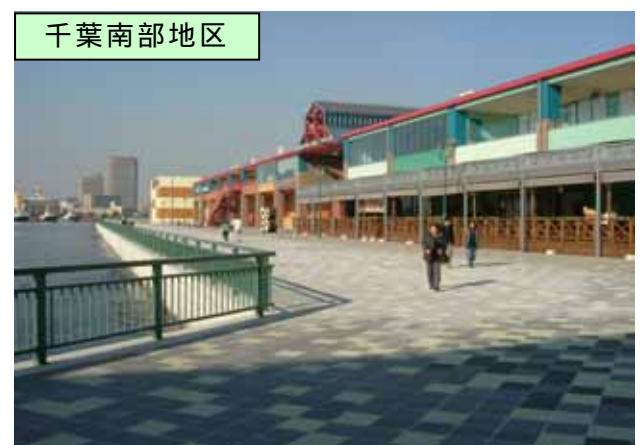
10m岸壁：干潮時でも水深10mが確保できる岸壁
