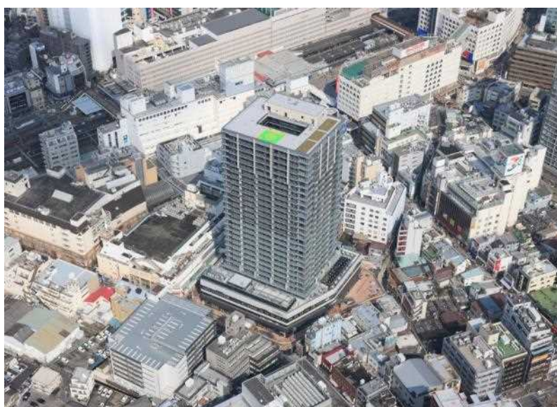
柏駅東口D街区第一地区
