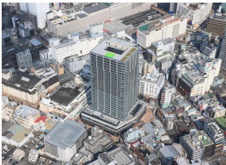
柏駅東口D街区第一地区
