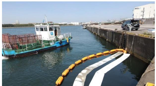
油吸着マットによる流出油の除去
