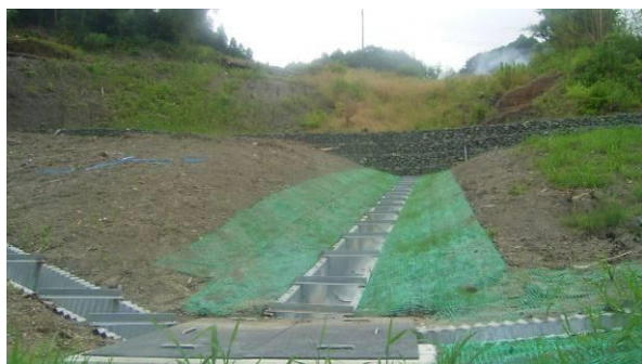
明暗渠工 (南房総市山田)
