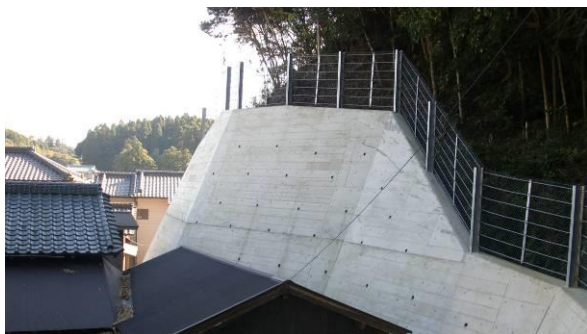
張りコンクリート工 (いすみ市大原)
