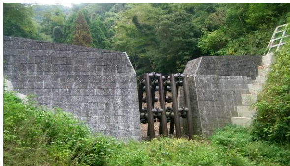
砂防堰堤工 (南房総市合戸)
