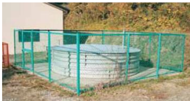
集水井工 (南房総市大井)
