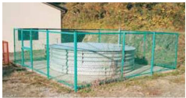
集水井工 (南房総市大井)
