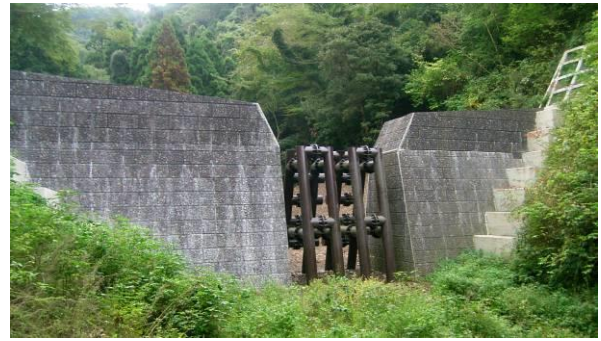
砂防堰堤工 (南房総市合戸)
