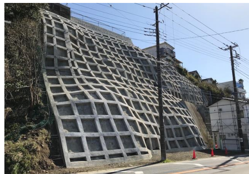
吹付法枠工 (勝浦市墨名)
