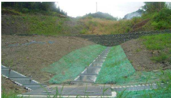
明暗渠工（南房総市山田）
