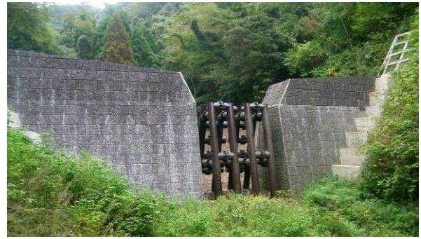
砂防堰堤工（南房総市合戸）
