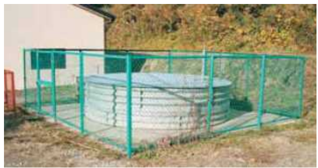
集水井工（南房総市大井）
