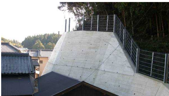
張りコンクリート工（いすみ市大原）
