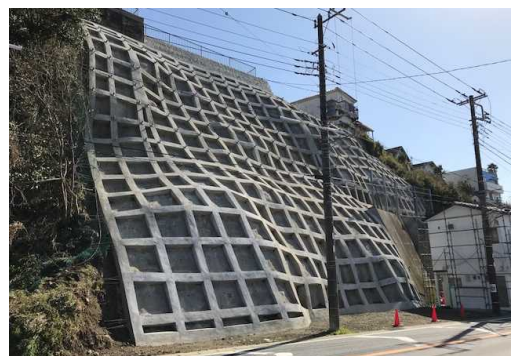
吹付法枠工（勝浦市墨名）
