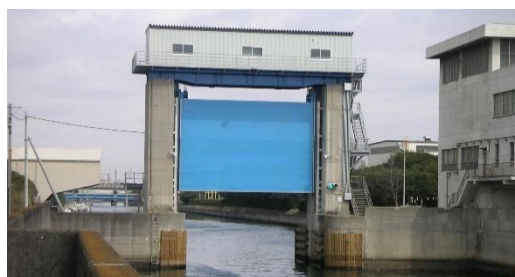
高潮対策事業 千葉港海岸（船橋地区）
