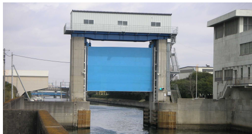
高潮対策事業 千葉港海岸（船橋地区）
