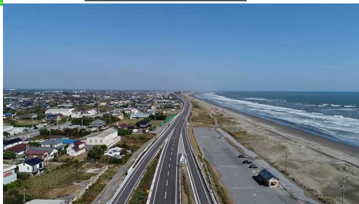
九十九里浜沿岸海岸津波対策事業（九十九里有料道路かさ上げ）
