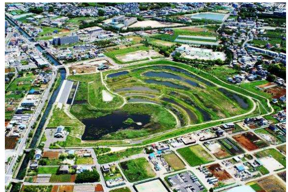
大柏川第一調節池 (市川市北方町)
