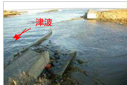
津波による堤防決壊(二)木戸川
