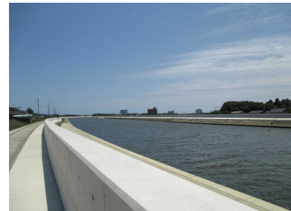
堤防かさ上げ工事完成状況(二)南白亀川
